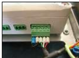
6) Connect output module cable
