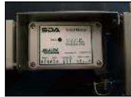
5) Replace lid on output module
