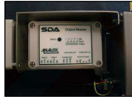
5) Replace lid on output module
